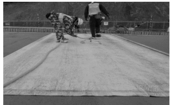
(b) 真空脱水処理の様子
