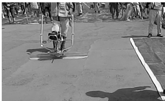
(a) 振動スクリードによる再振動の風景
