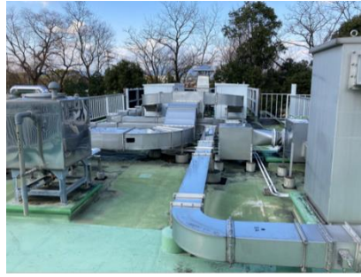
図2 屋上の排気ダクト
