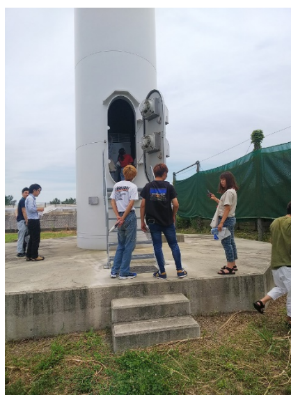
風力発電設備
