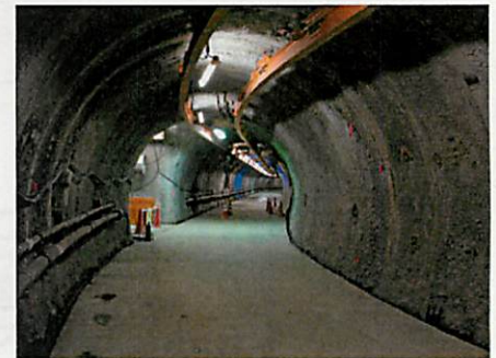
深度350m調査坑道 (平成26年2月25日撮影) 10
