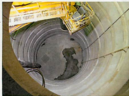
西立坑 (平成26年3月26日撮影)
