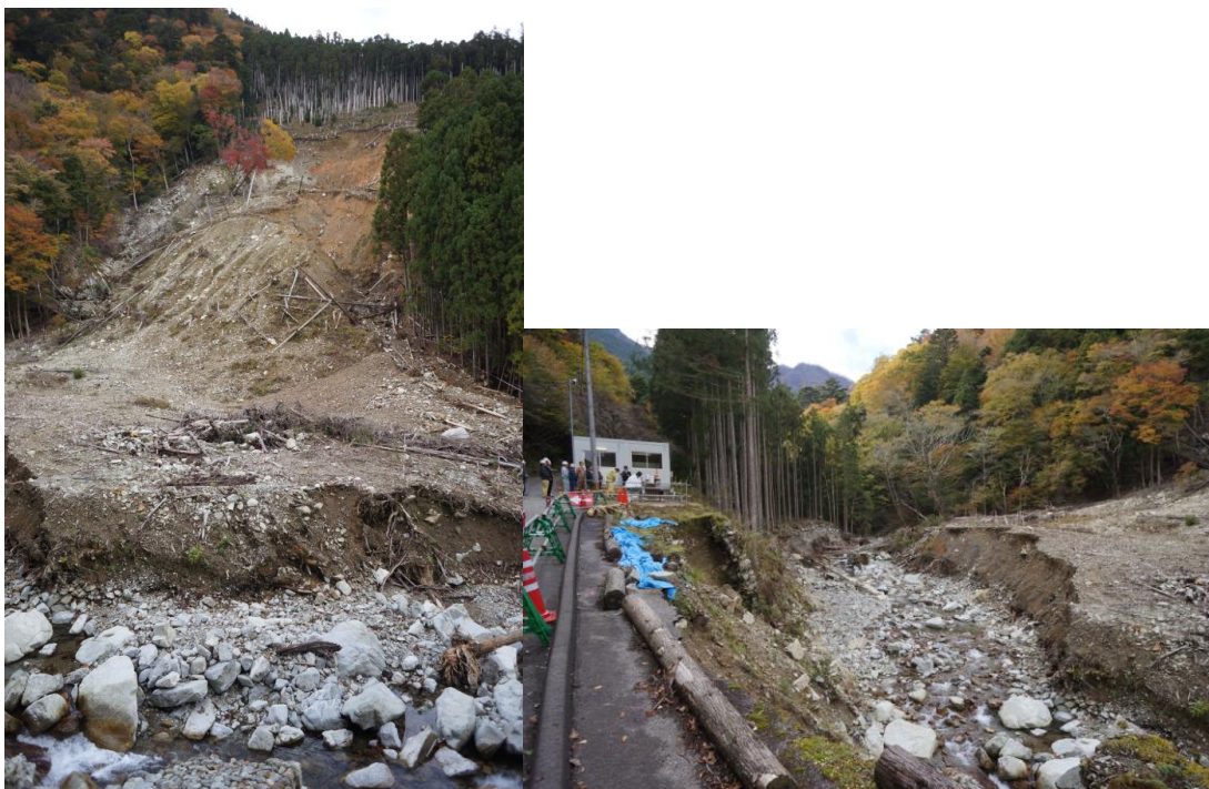
図2 昨年度の台風により崩落した山の法面（演習林内）。本整備のための現地確認に向いたところ、ちょうど復旧工事のための地鎮祭が行われていました。通信や電力ケーブルが寸断されることもあり、常に災害への備えが必要です。
