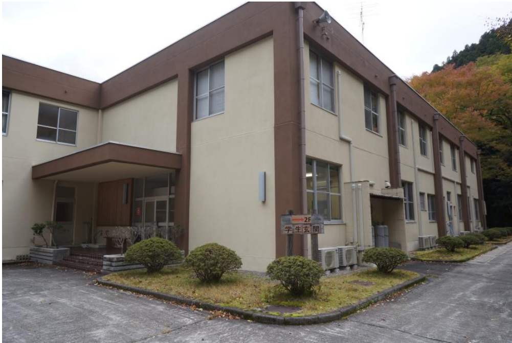
図1 深い森の中に突如として現れる鉄筋コンクリート造りの演習林管理棟
