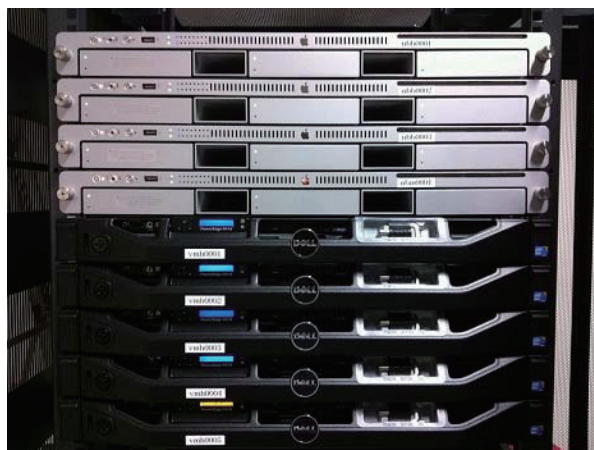
図-2 サーバ設置状況
