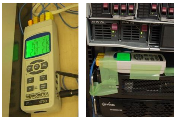
図 4 4 チャンネル温度 SD カード記録計 47SD (左図：装置の外観，右図：ブレードサーバー上に設置した状態)
