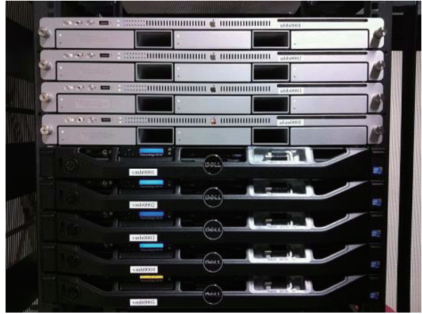
図-2 サーバ設置状況
