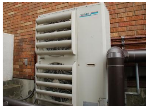
図 3 空調機器本体 (屋外に設置されている)
