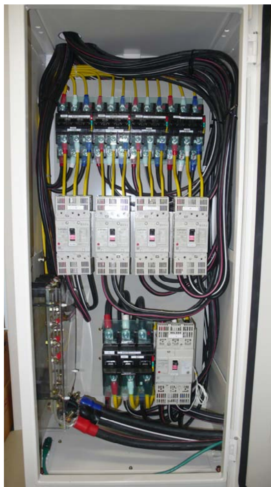
図2. 電気室切替 BOX
